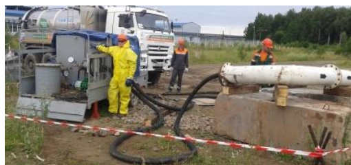
Промывка трубопровода горячими растворами
